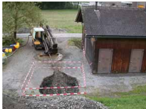
Grabenlose Leitungsverlegung, Kanalquerung bei der DRM Ruggell
